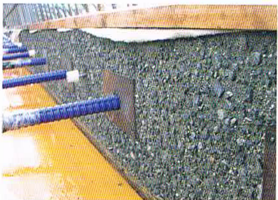
土木：洗出し後の打ち継ぎ面
