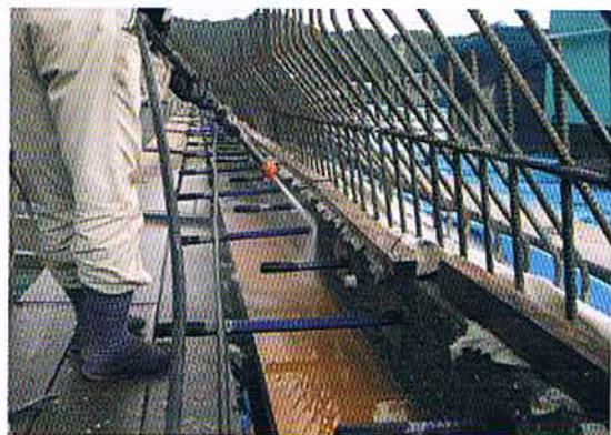
土木：橋梁での水洗出し作業中
