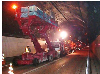
道路トンネル (ミキサー車にて搬入)
