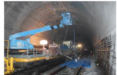
鉄道トンネル (専用列車にて搬入)
