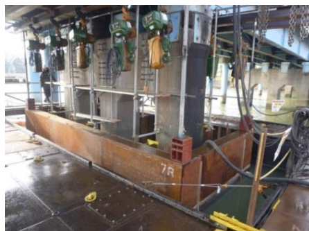
河川内橋脚の鋼板巻き立て工事への適用
