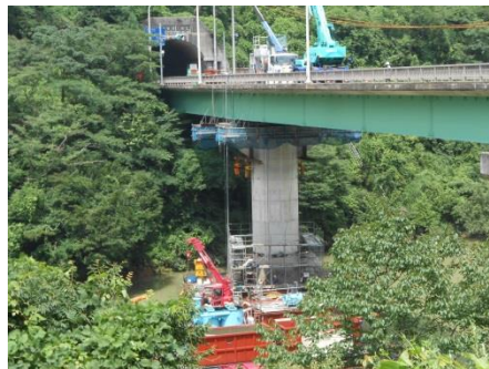
河川内橋脚の鋼板巻き立て工事への適用
