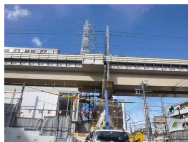
車載フラントと橋脚鋼板巻き立て工事への適用
