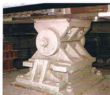
支承取換え工事
