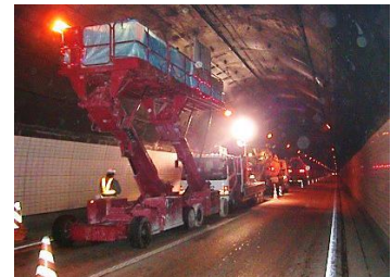
道路トンネル用 (ミキサー車にて搬入)
